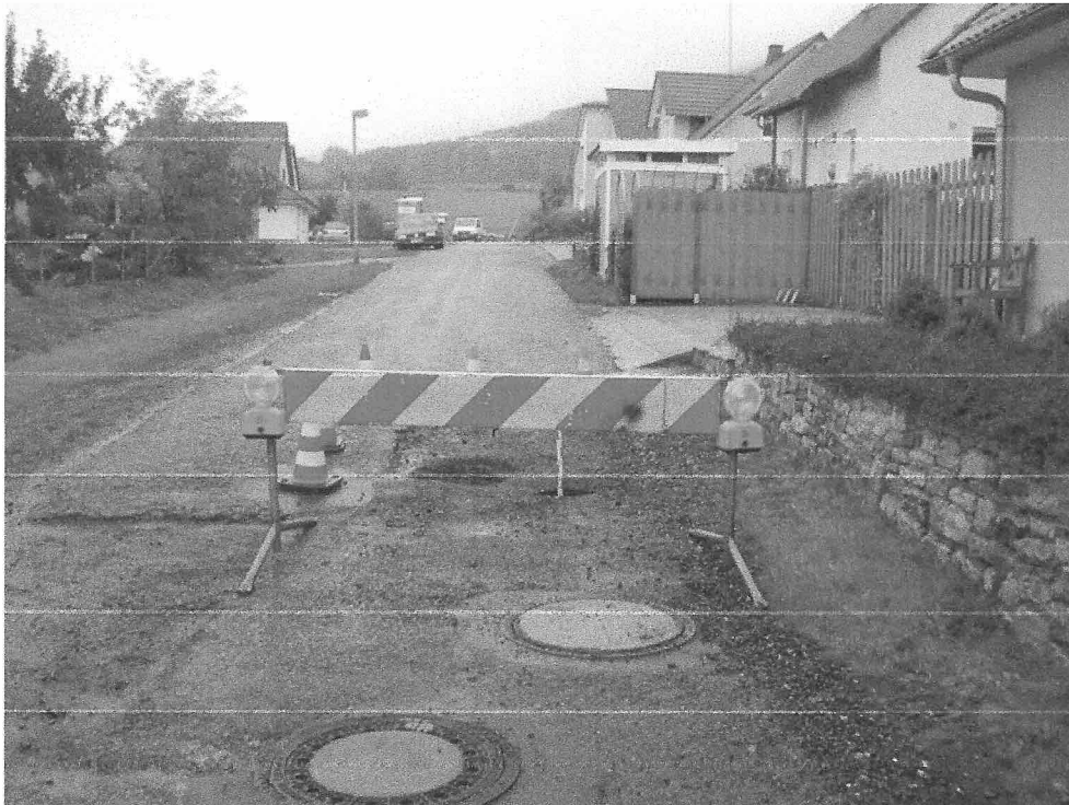
Foto 1: Blick nach Süden, rechts befindet sich das Haus Im Burgfeld Nr. 29.
